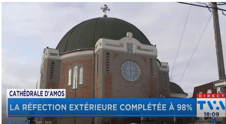
Le projet de restauration de l'extérieur de la cathédrale incluait le renouvellement du cuivre à la base du dôme, la restauration des fenêtres et des mosaïques, ainsi que le remplacement de chacun des 50 000 briques et des 3 500 pierres.
