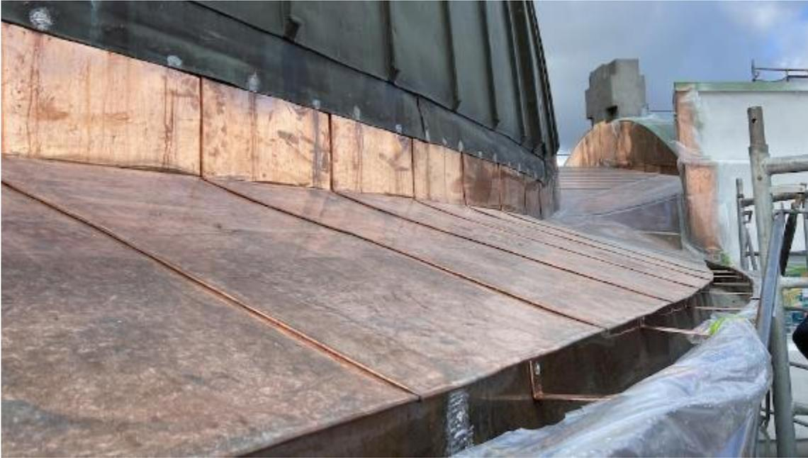
On a procédé au remplacement des plaques de cuivre sur la couronne des dômes et des gouttières, qui sont aussi en cuivre.
